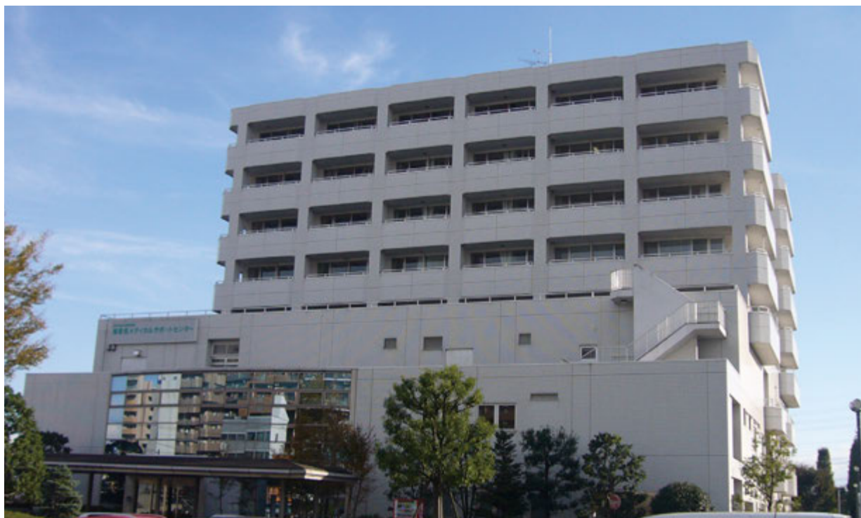
海老名メディカルサポートセンター 外観
