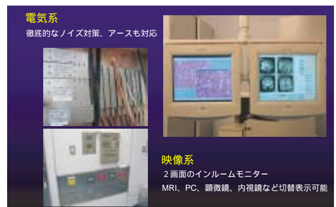
図11：MRI手術室特有の電気系統と映像用システム
