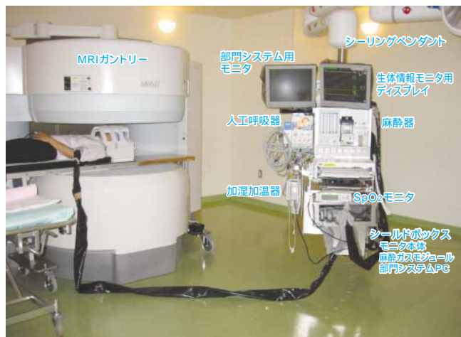
図3：MRIガントリーとシーリングペンダント搭載の機器
