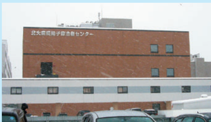
北大病院陽子線治療センター 外観
