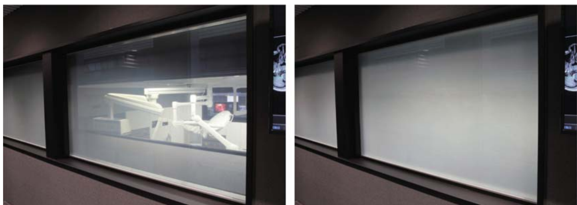
図3 先端治療をエリア外から直接見学できるオブザベーションルーム。瞬間調光ガラスにより、視界・光を手術室内からコントロールできる。
